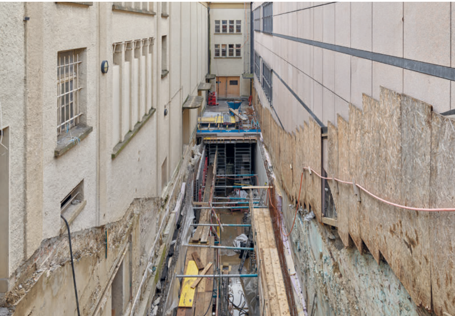
Installation de l'écran de la salle historique, devant les haut-parleurs du mur THX. ↑ Creuse dans l'impasse pour la création du foyer de la nouvelle salle. ↓
