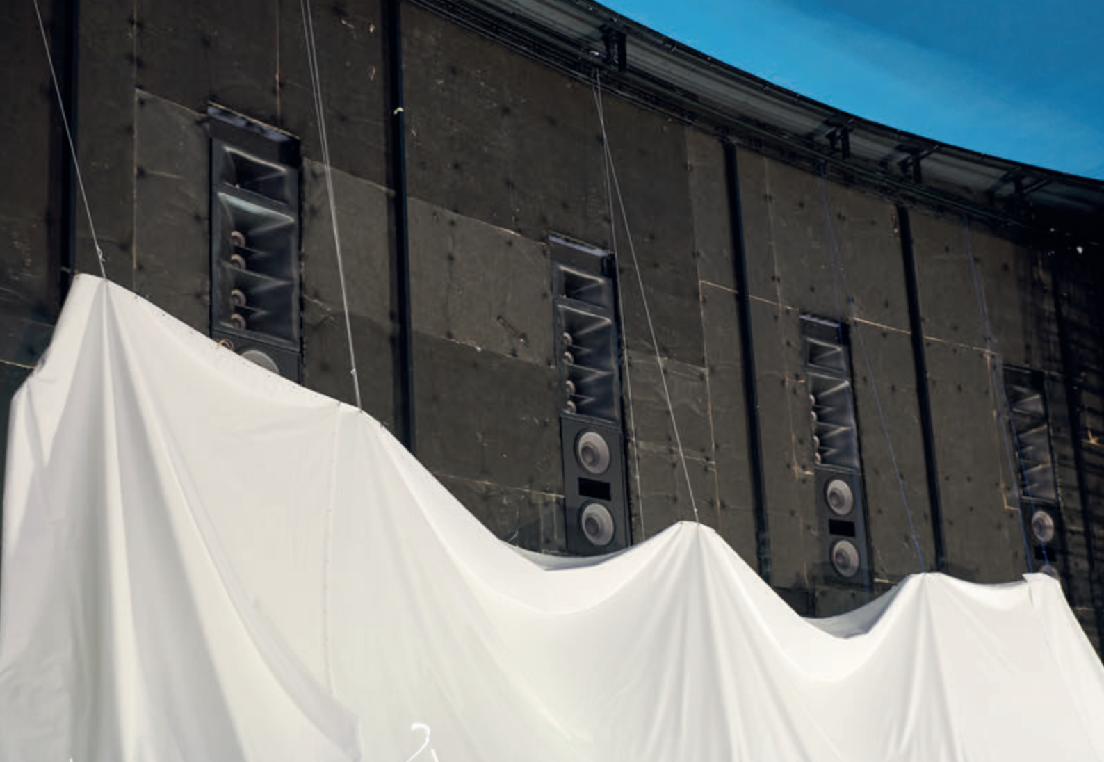
Installation de l'écran de la salle historique, devant les haut-parleurs du mur THX. ↑ Creuse dans l'impasse pour la création du foyer de la nouvelle salle. ↓
