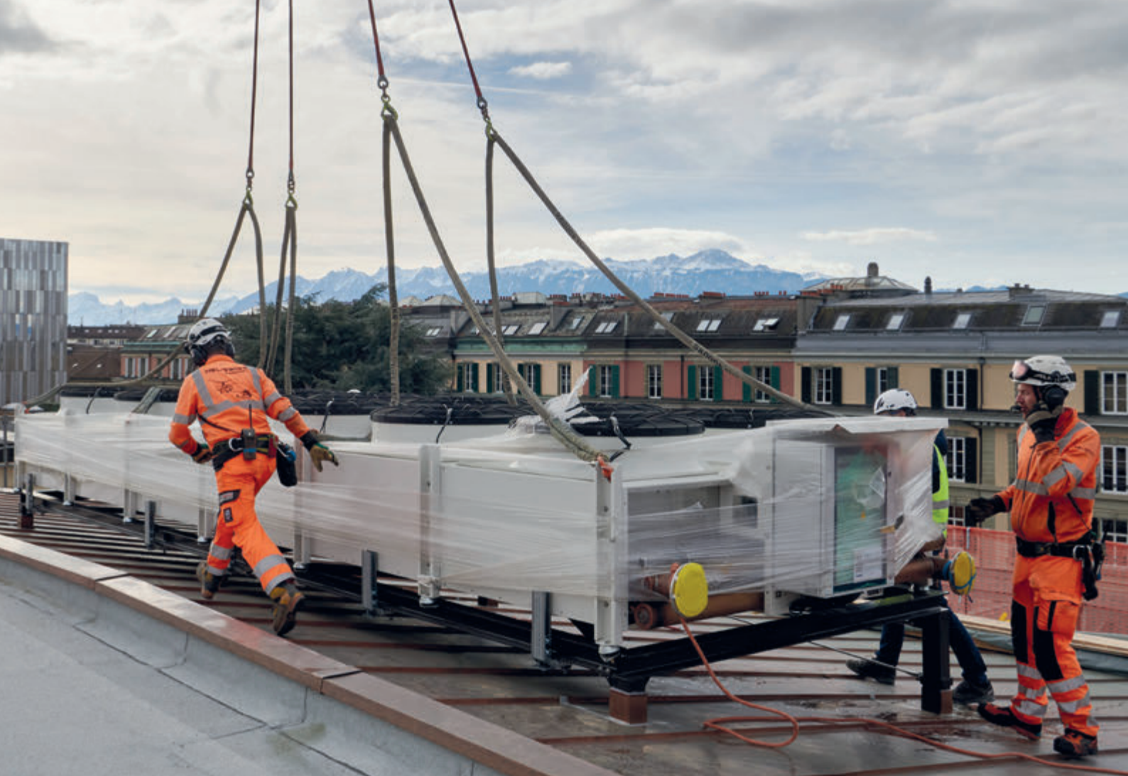
↑ Pose par hélicoptère de l'aérorefroidisseur sur le toit du Capitole. ↓ Peinture du plafond bleu de la salle historique qui a retrouvé tout son éclat.
